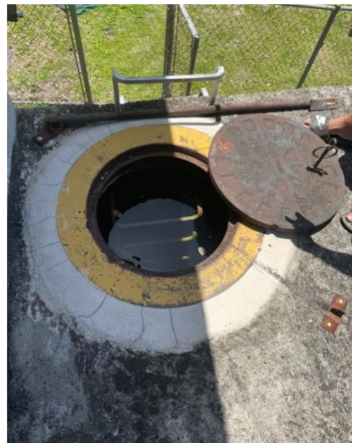
Figura 11 Agua tratada en el tanque de distribución
