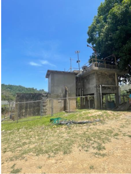
Figura 8 Estructura de tanque de arena y tanque de distribución
